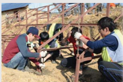
태양광 패널을 설치하기 위한 철골프레임 공사
